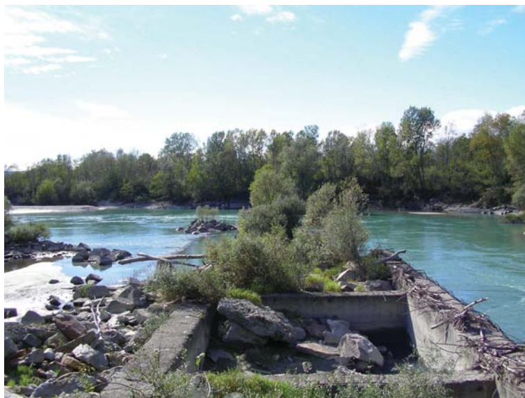
Figura 22. Traversa ormai collassata nei pressi della regione Campasso; essendo venuta meno la sua funzione se ne auspica la definitiva rimozione.
