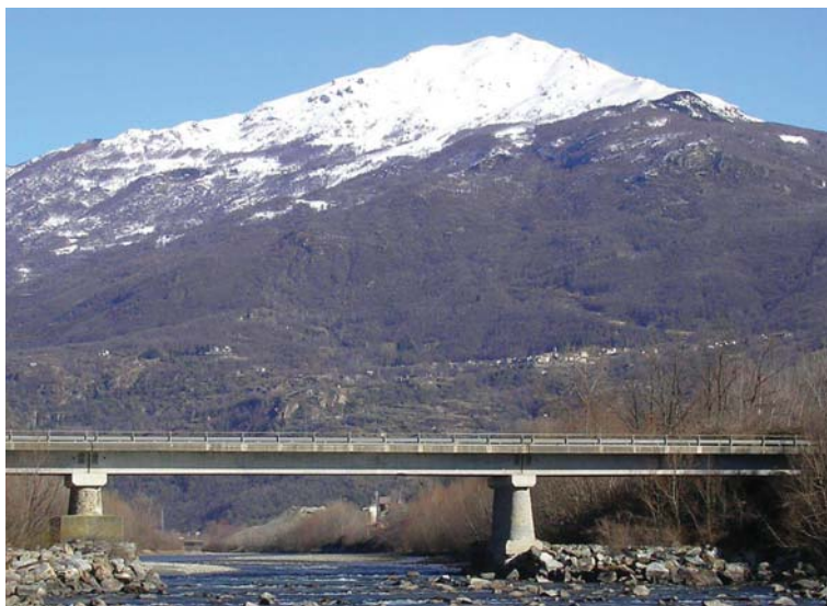
Figura 12. Ponte di Borgofranco-Baio Dora: in seguito all'abbassamento dell'alveo di circa 2,5 m, in un tratto in forte erosione di fondo, è stata realizzata una copertura con massi a protezione della base delle pile.
