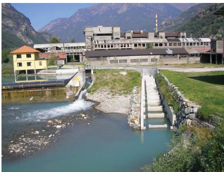
Figura 3. Quincinetto: scala di risalita per i pesci in corrispondenza della traversa.
