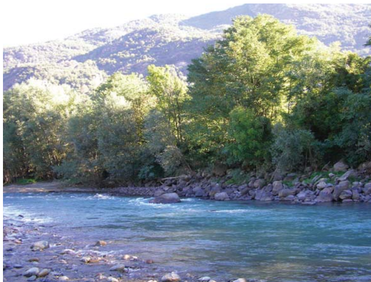
Figura 6 . Difesa spondale in massi, in parte ricoperta da vegetazione spontanea, nei pressi della SS 26 in corrispondenza della confluenza con il Rio Renanchio.
