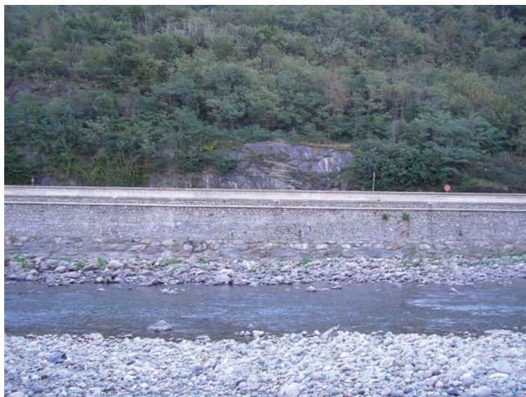
Figura 4. Difesa di sponda in cemento e pietrame in corrispondenza SS 26, a monte di Airale.
