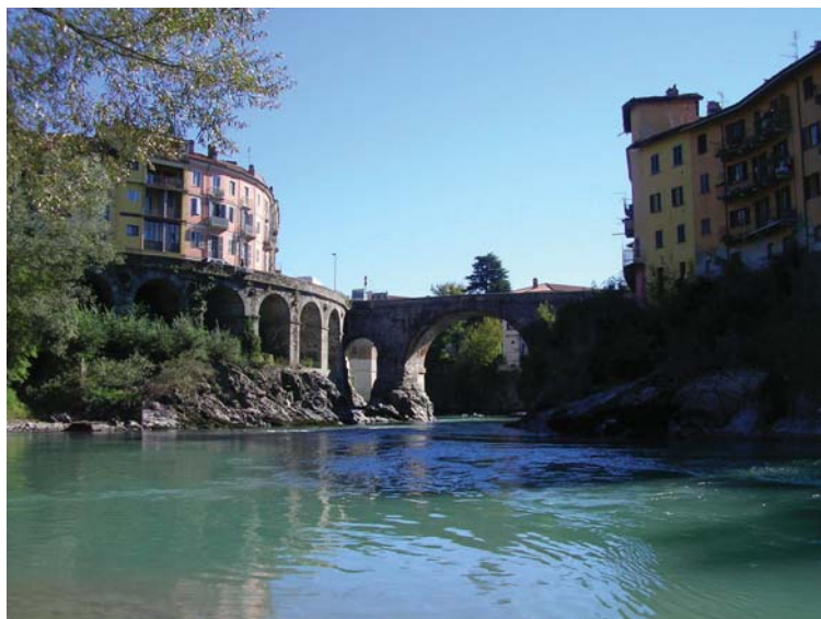
Figura 20. Il ponte ad arco della stretta di Ivrea. La sezione non consente il deflusso delle portate di piena eccezionale; le acque in eccesso vengono convogliate nel Rio Ribes attraverso l'incile di Fiorano.
